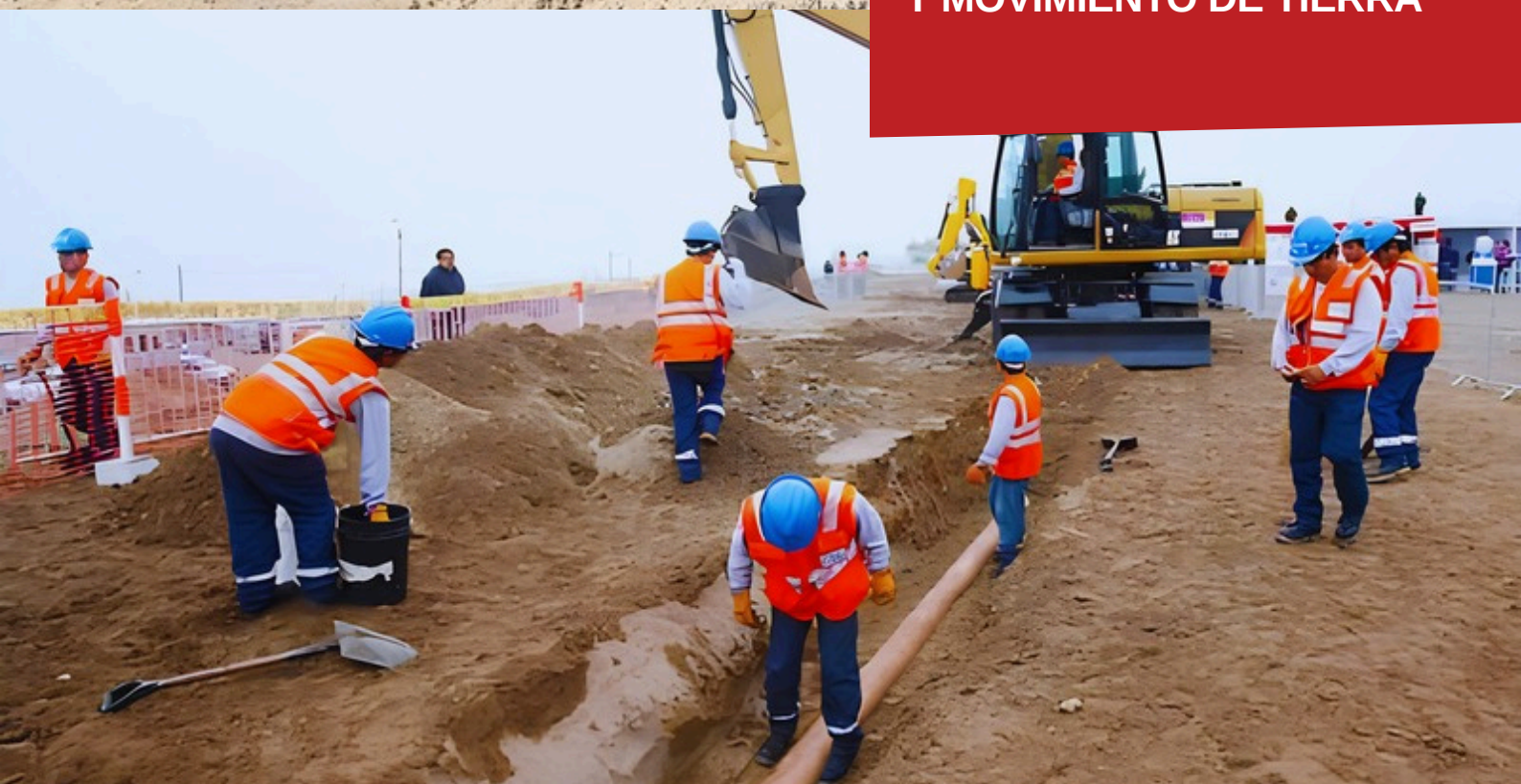
APERTURA DE CARRETERAS Y MOVIMIENTO DE TIERRA
